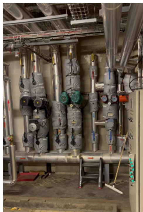
Départs réseaux de chauffage
